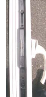
② Fermeture centrale (crémone et tringle)
